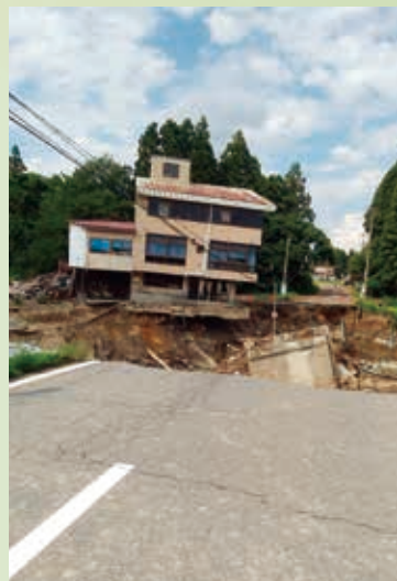
▲豪雨によって崩落した飯豊町の「大巻橋」
