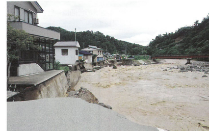
▲大蔵村の銅山川の道路崩落現場
