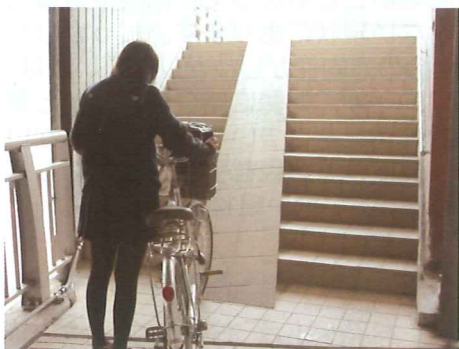
▲センターに自転車用スロープを設置
