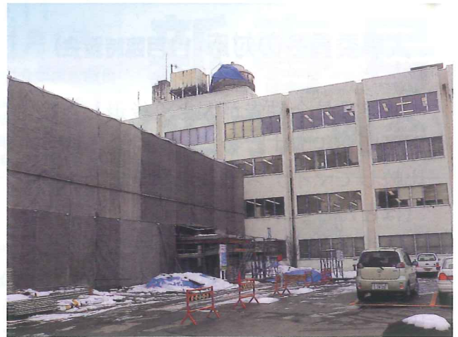
耐震工事を行っている庁舎
